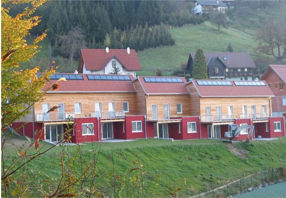
**Abbildung 4:** Wohnhausanlage Wernersdorf, tragende Konstruktion aus Brettsperrholz
