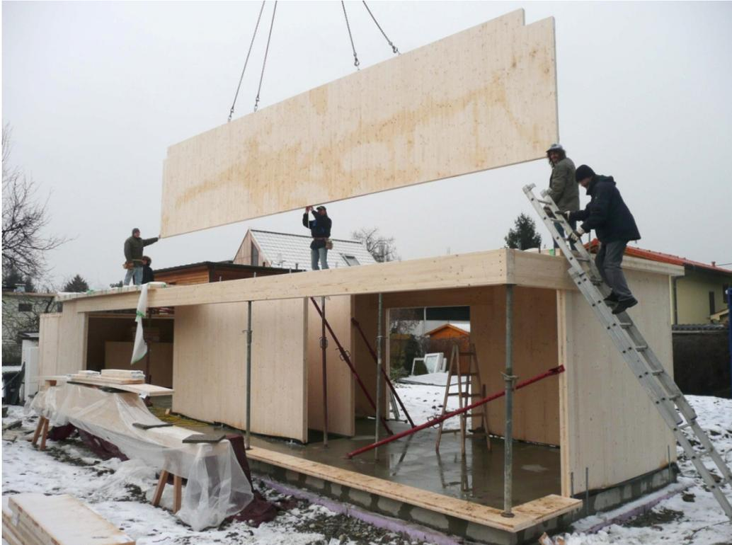
**Abbildung 3:** Ökonomisches Bauen mit großflächigen Brettsperrholzelementen
